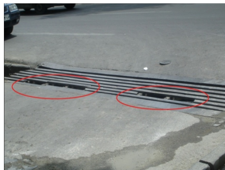
تصویر ۴: نمونه‌ای از یک پل ارتباطی ناهمگام نامناسب برای عبور معلولین (منبع: نگارنده، ۱۳۹۰)
