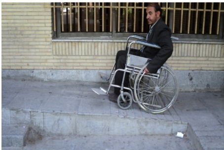
تصویر ۸: نصب‌نشدن دستگیره در طرفین رامپ (منبع: نگارنده، ۱۳۹۰)
